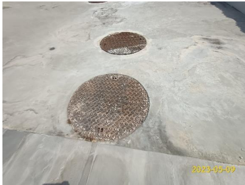
ฝาปิดถังเก็บน้ำชั้นดาดฟ้า
