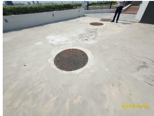
ฝาปิดถังเก็บน้ำชั้นดาดฟ้า
